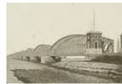
Moerdijk Bridge (photo Pieter Oosterhuis, 1871).
